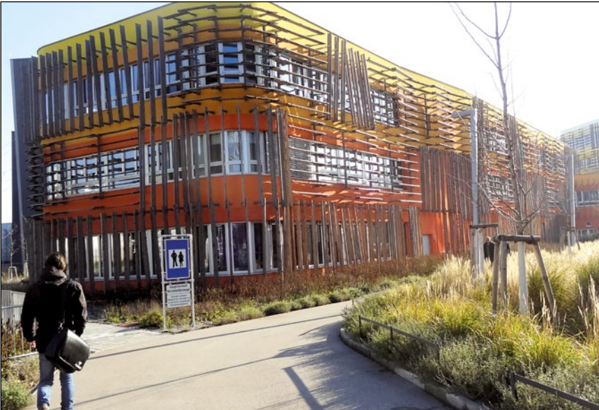
Abb. 3: Vorgehängter Sonnenschutz aus senkrecht angebrachten, naturbelassenen Holzpfosten.
